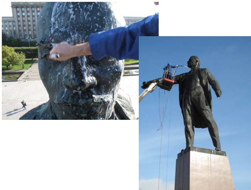
Во время проведения работ.
